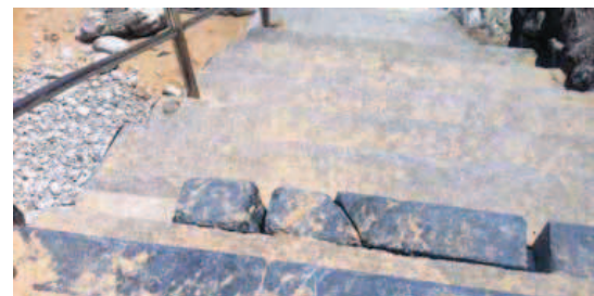
Peldaño suelto en las escaleras de acceso a la playa llanisca. :: e. c.
